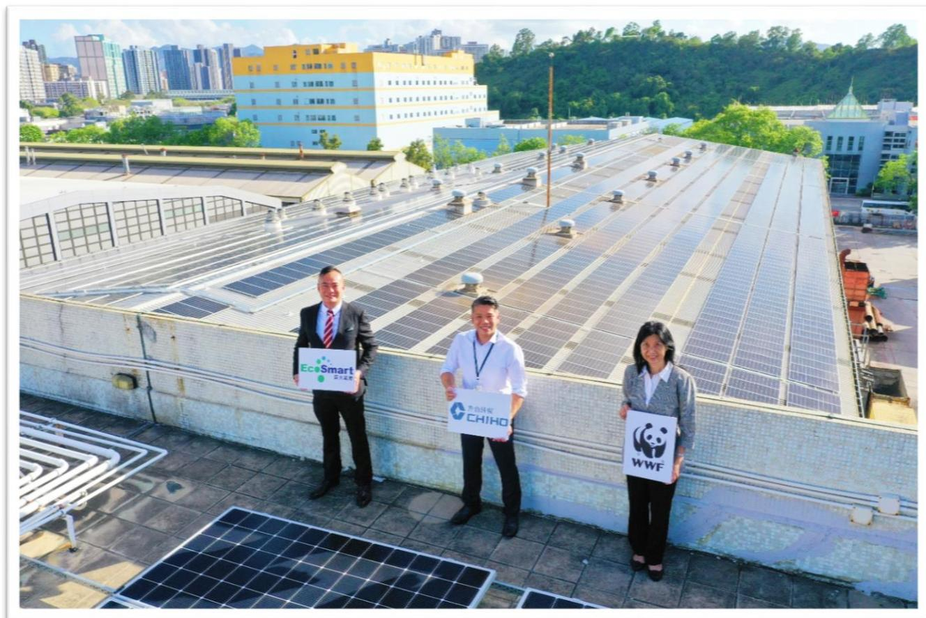
同时，Samson Lui 雷永雄对所有参与本次项目的单位和个人表示诚挚感谢。本次 EcoSmart 星火能源为齐合环保香港工厂所设计的太阳能发电系统，采用市场上最高效能之一的韩国 LG 太阳能板，除了可抵御强风，减低性能退化速度，其光涂层还有助于减少在高温时流失的能量。配合最先进 IOT 物联网科技的 Enerwise 实时检测系统，接驳香港首创的星火太阳能实时检测中心，不间断测量太阳辐照度推算光伏的性能，并产生大数据以作分析用途，确保发电效能及系统运作无休。此系统的太阳能板总数量为 2437 块，额定功率为 1 兆瓦 (MW)，每年产电量 1,013,375 度 (约等于 241 个香港家庭用电量)，估计能有效减少每年约 572,000 公斤碳排放量 (约等于种植 26,217 棵树)，为香港碳减排贡献了一份力量。
